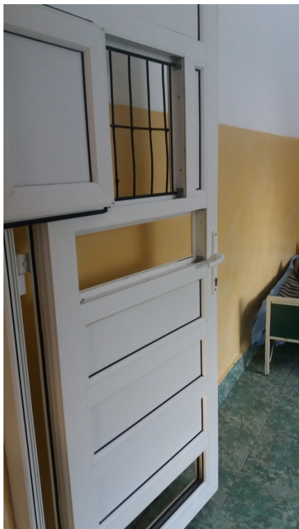
IMAGINE 1 – UȘA CAMEREI FOLOSITE PE POST DE IZOLATOR
